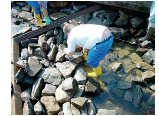
Einbau der Sohlbefestigung (Bootsgasse)
